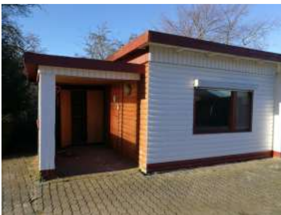
Foto 21: Gebäude mit Holzverkleidung auf dem Grundstück Sundweg 101, Südostseite (Lage s. Abb. 4: Gebäude 101a)
