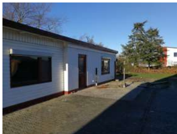
Foto 22: Gebäude mit Holzverkleidung auf dem Grundstück Sundweg 101, Ostseite (Lage s. Foto 21)
