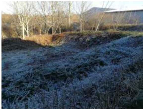
Foto 27: Grünanlage nördlich des Lidl-Verkaufsbauwerks mit Regenwasserversickerungsanlage
