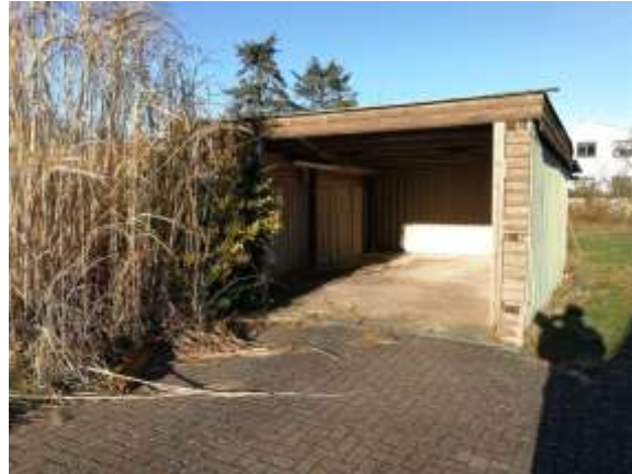
Foto 18: Garage auf dem Grundstück Sundweg 103, Südseite (Lage s. Abb. 4: Gebäude 103b)
