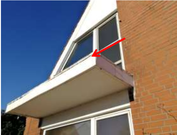
Foto 5: Wohnhaus Sundweg 105, Südseite, Detail mit Spaltenstrukturen (Pfeil), (Lage s. Foto 4)
