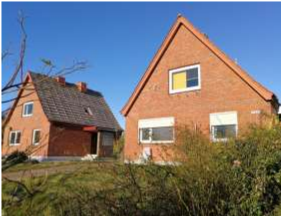
Foto 13: Wohnhäuser Sundweg 101 (links) und 103 (rechts), Straßenseite (Lage s. Abb. 4: Gebäude 101 und 103)
