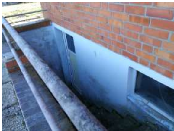
Foto 20: Wohnhaus Sundweg 101, Nordseite mit Kellereingang, hier ohne Spalten und anderen Öffnungen (Lage s. Foto 19)
