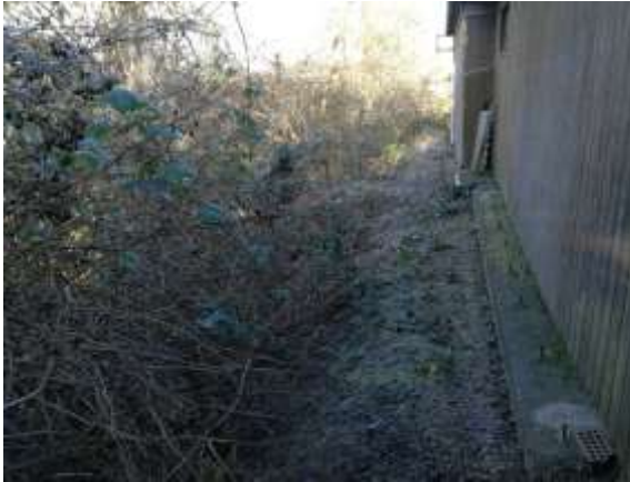
Foto 23: Gebäude mit Holzverkleidung auf dem Grundstück Sundweg 101, Westseite (Lage s. Foto 21), links Gebüsche auf der Böschung zum Fließgewässer „Jordan“
