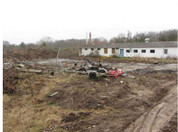
Foto 8: Gebäude 4 im Hintergrund, verblendet wie Gebäude 1-3
