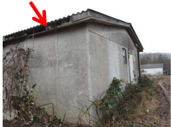
Foto 6: Gebäude 3: Ecke ähnlich Gebäude 1 und 2, Spalten und Nischen vorhanden (s. Pfeil)
