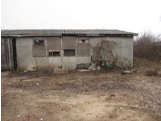
Foto 5: Gebäude 3 mit Nutzung für handwerkliche Arbeiten, zahlreiche Spalten und Nischen vorhanden
