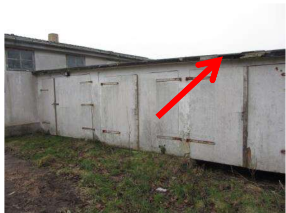
Foto 10: Gebäude 4 mit Garagenanhang, Spalten und Nischen vorhanden (s. Pfeil)
