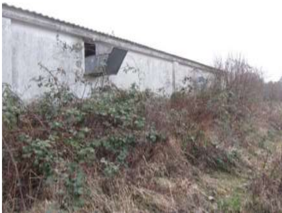
Foto 1: Gebäude 1: Lagerhalle mit Betonverblendung, Eternit-Welldach
