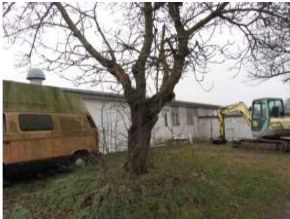
Foto 11: Gebäude 4 mit Baum im Nahbereich
