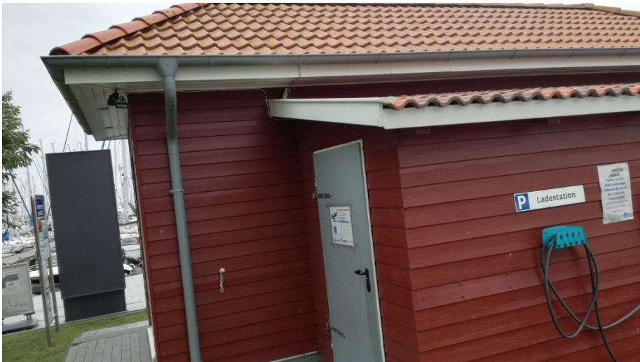
Rückseite mit Holzanbau mit für Fledermäuse zugänglichem Spalt
