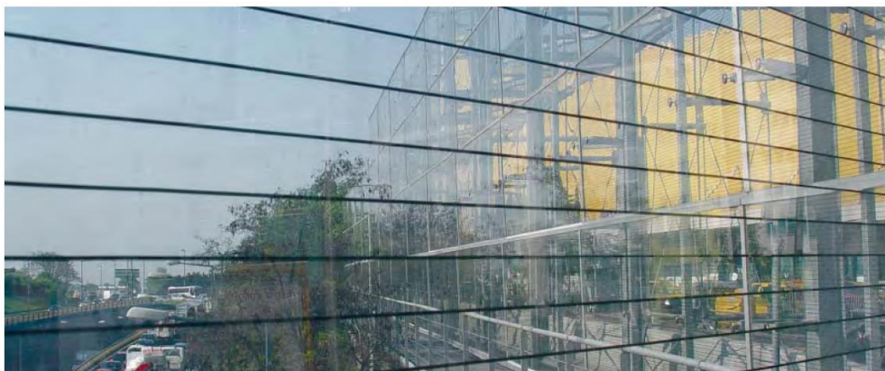
Schwarze, horizontale Linien von 2 mm Breite und einem Lichtmass von 28 mm schnitten in Laborversuchen wider Erwarten sehr gut ab. Wo es auf möglichst ungetrübte Durchsicht ankommt, könnte das eine gute Lösung sein.
