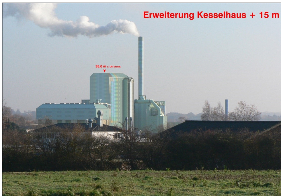
Abbildung 3: Erweiterung außerhalb der Zulässigkeit des B-Planes
